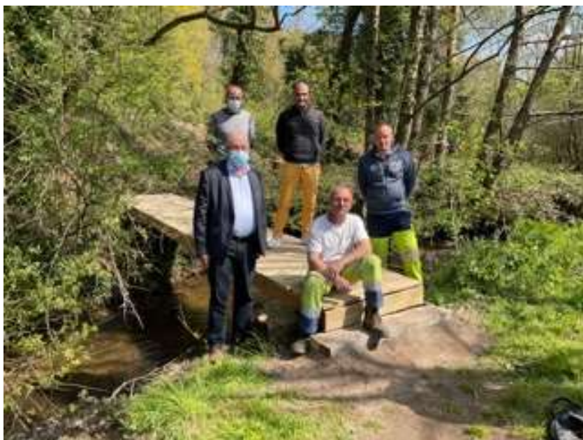
Réalisation d'une passerelle sur le ruisseau du Prat al Lan par les agents de la commune.
